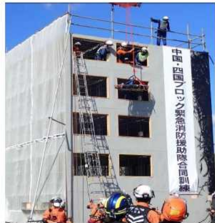
養生シートイメージ
