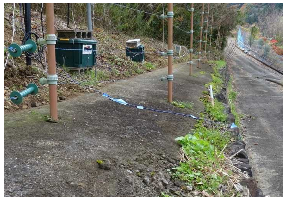
写真2 鉄鋼スラグ舗装の敷設10年後の状況
