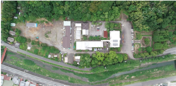
試験場を上空約150mから撮影 R5.6.1
