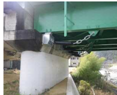
落橋防止の設置
