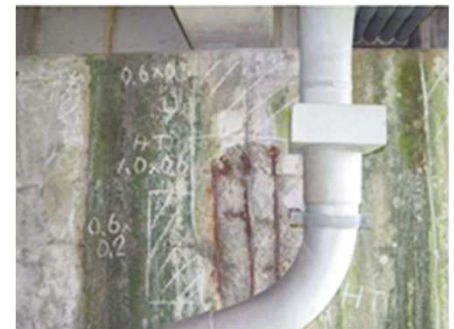
コンクリートの剥離 (橋脚) の補修
