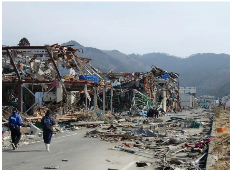
宮ヶ崎地区(水産加工団地)水産加工施設の被災状況
