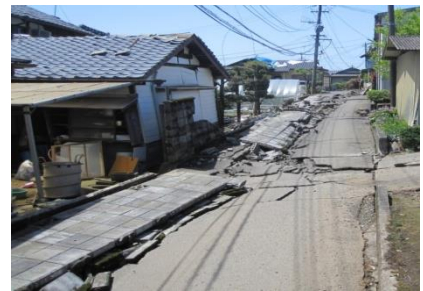
熊本地震で倒壊したブロック塀
