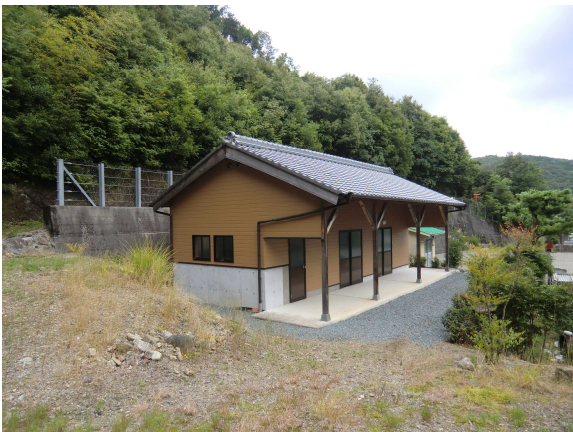
(備蓄倉庫の外観)
