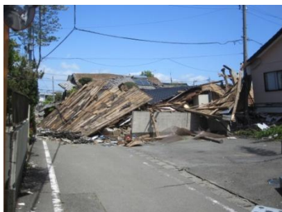
倒壊して道を完全にふさいだ家屋
