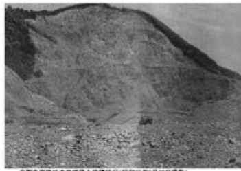
金剛寺自然地の崩壊後土砂堆積状況(昭和28年4月30日撮影)
