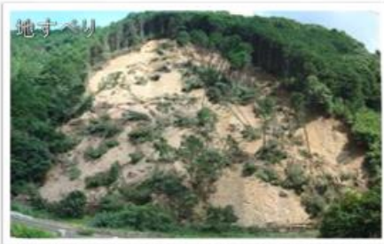
橋本市慶賀野地区(紀伊半島大水害)
