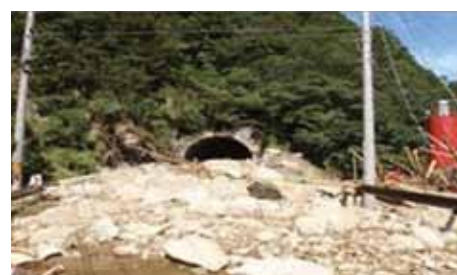
国道168号（新宮市）
