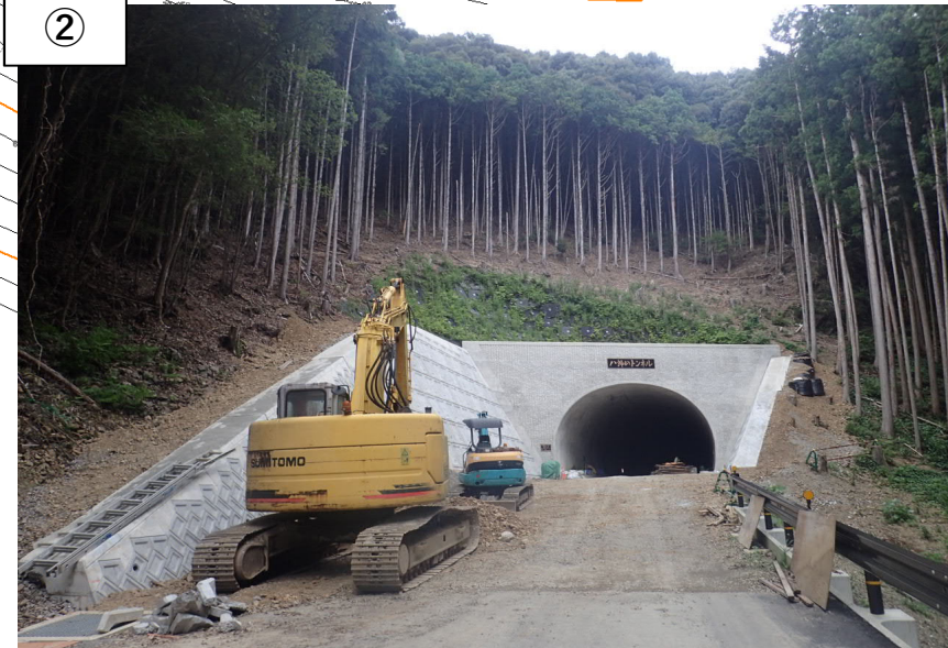
終点側坑口の状況 撮影日; 令和5年9月4日
