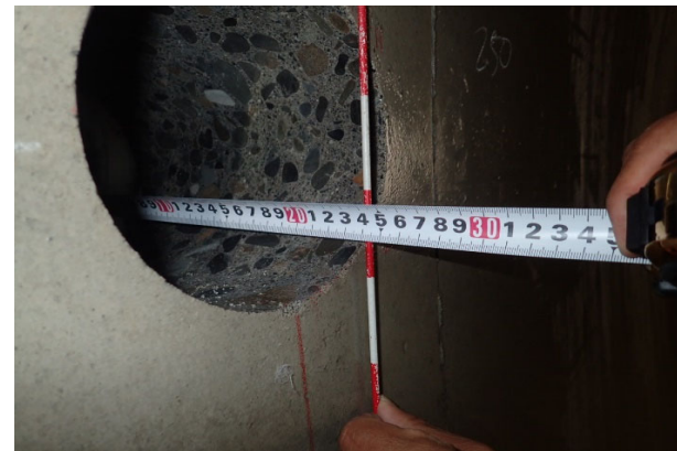
コア孔による覆工厚の確認
