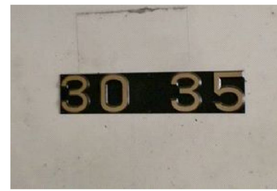
覆工厚の銘板
