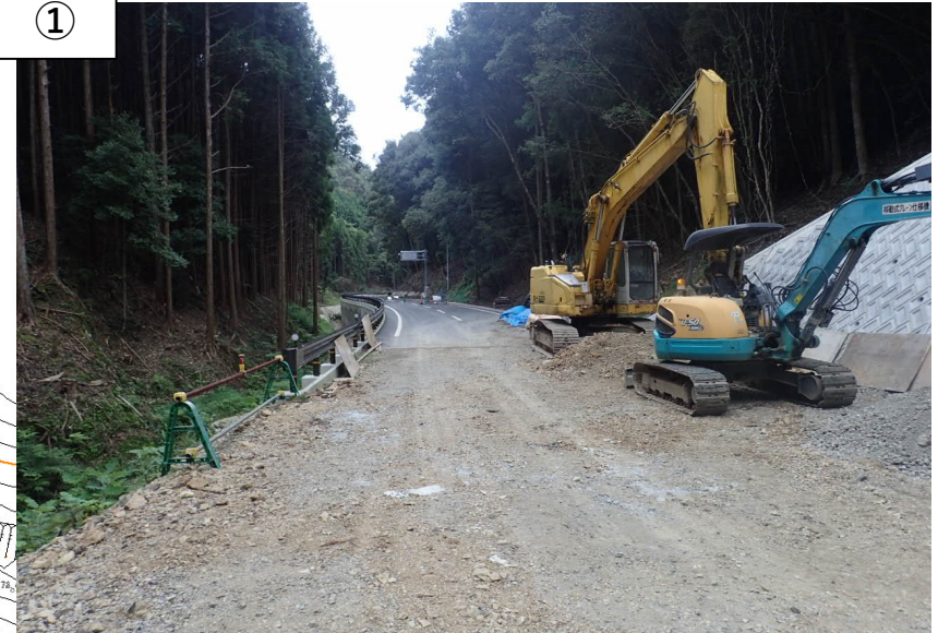
終点側坑口の明り工の状況 撮影日; 令和5年9月4日
