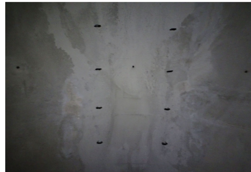
トンネル天端の配線支持金物
