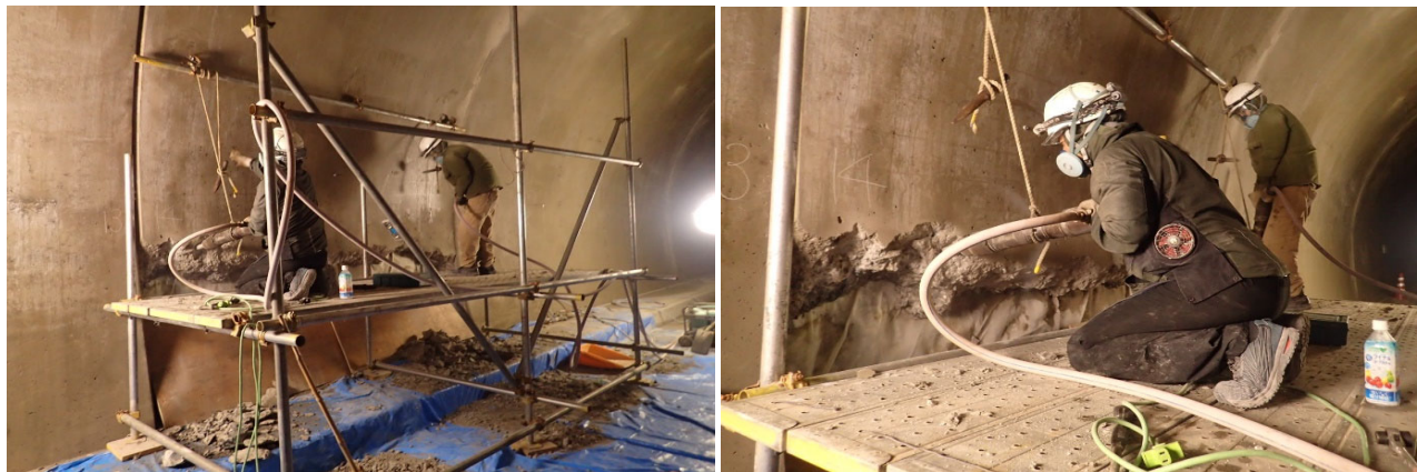
覆工コンクリートのはつり状況
