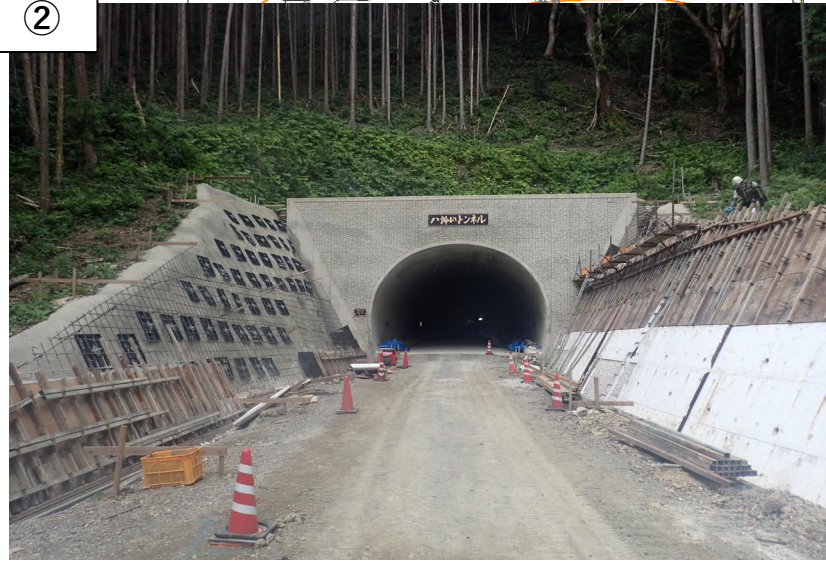
起点側坑口の状況 撮影日: 令和5年9月4日
