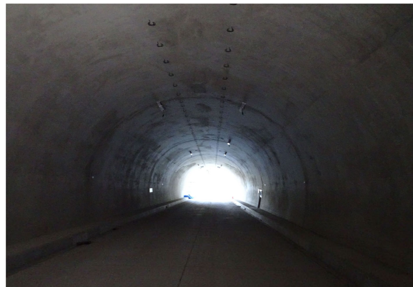
トンネル坑内の状況
