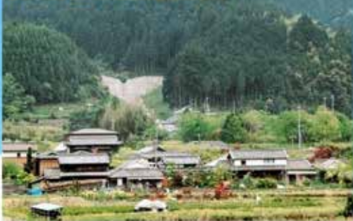
日高川水系 奥の谷川砂防堰堤(日高川町)
