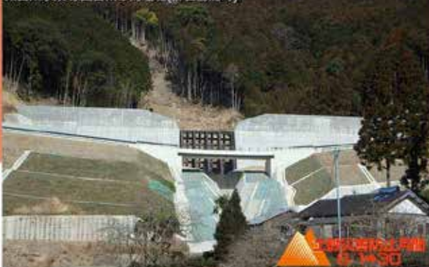
太田川水系 赤倉谷川砂防堰堤(那智勝浦町)
