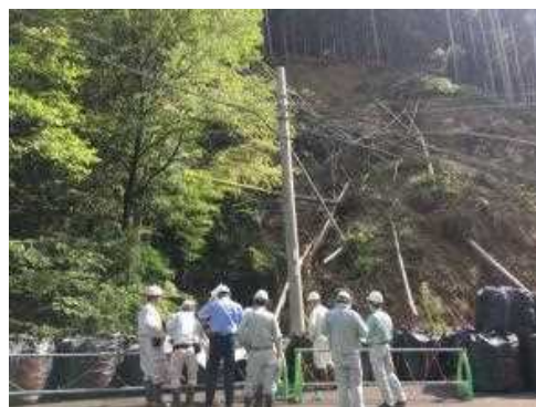
現地調査実施状況（有田川町内）
