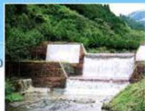
新富川水系 なげり谷川 (新富市熊野川町) 間伐材残存型枠使用
