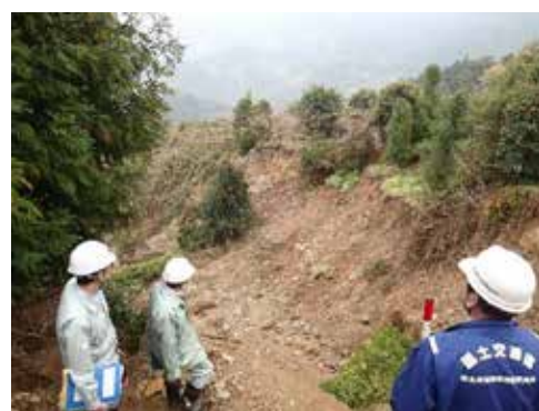
現地調査実施状況（海南市地内）
