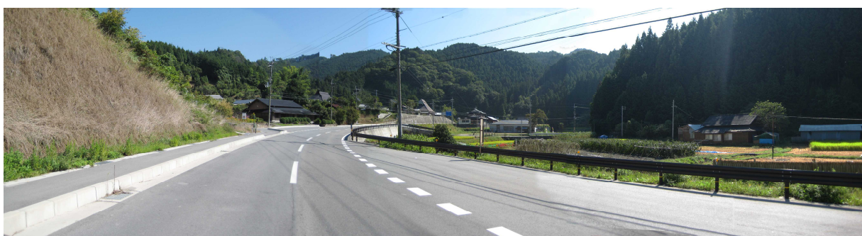
国道 480 号沿道の景観
