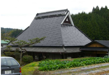
特徴的な建築物 茅葺き屋根（トタン屋根）の住宅
