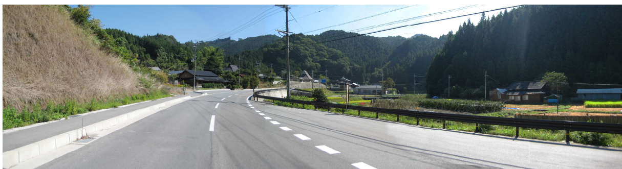
国道 480 号沿道の景観
