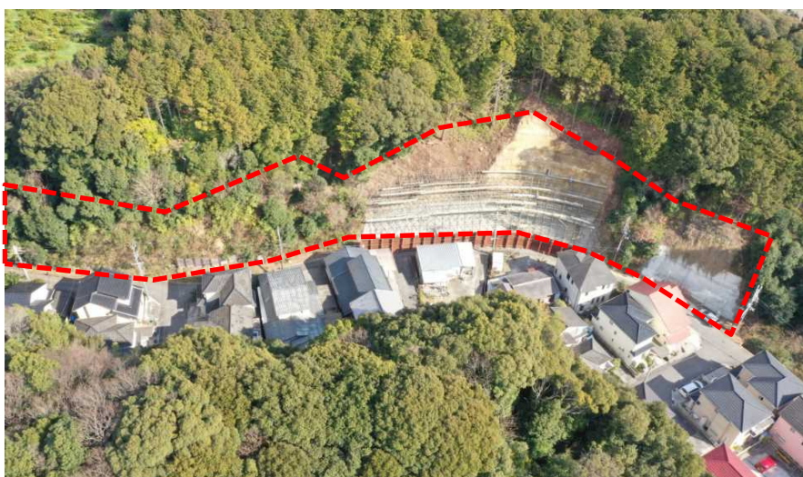
急傾斜地崩壊対策工事（寺長（3）地区）
