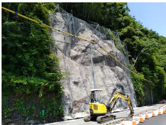
法面補強事例（かつらぎ桃山線）
