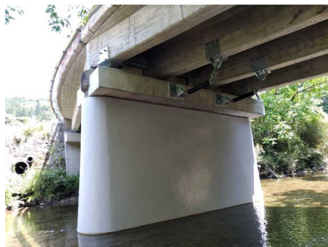
橋梁耐震事例（高野口野上線 前川橋）
