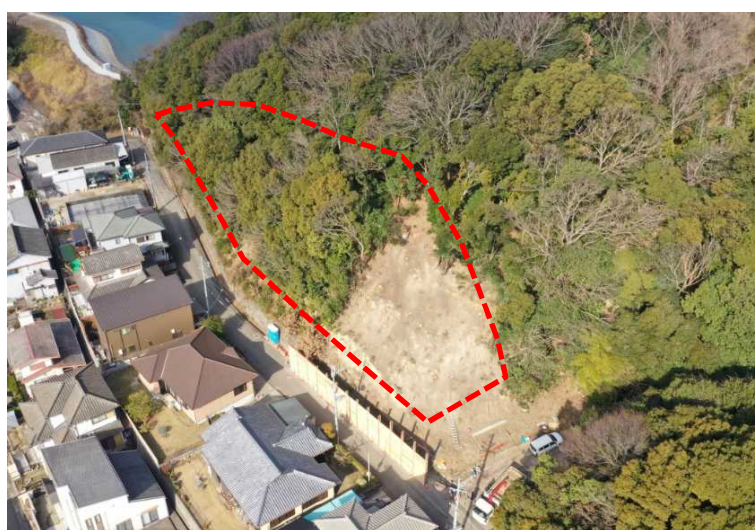
急傾斜地崩壊対策工事（山地区）
