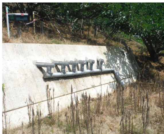
対策工事（集水ボーリング工）
