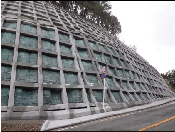
法面補強工事
