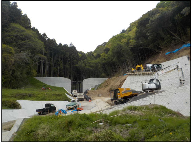
【砂防えん堤整備状況】
