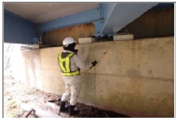
橋梁点検（打音検査）
