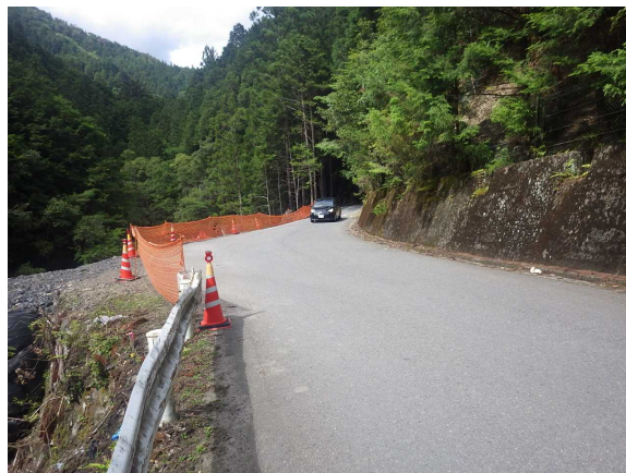
東又工区(工事中)
