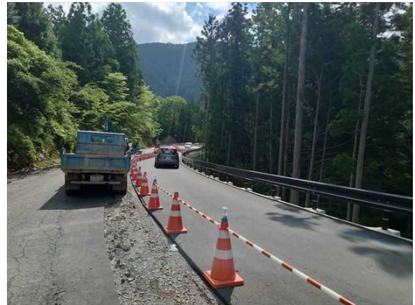
【国道480号（花園久木）工事中】
