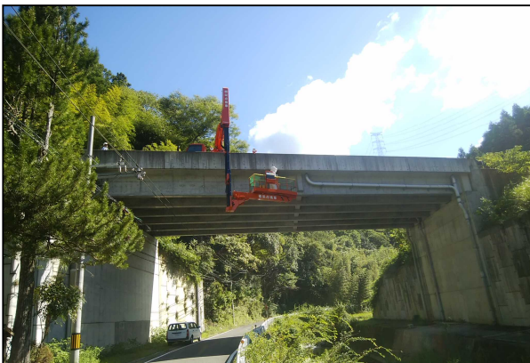
橋梁点検（橋梁点検車）
