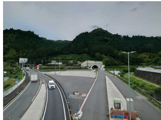
【(仮称)新紀見トンネル和歌山側】
