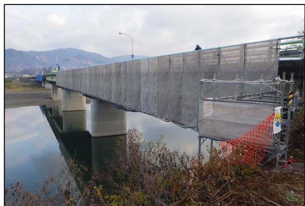
橋梁補修工事
