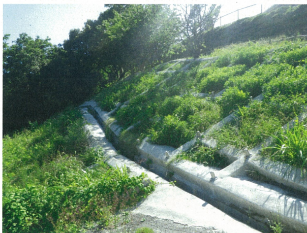
東岩代地区（みなべ町東岩代地内）
