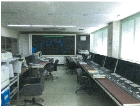
ダム管理用制御処理設備更新工事
