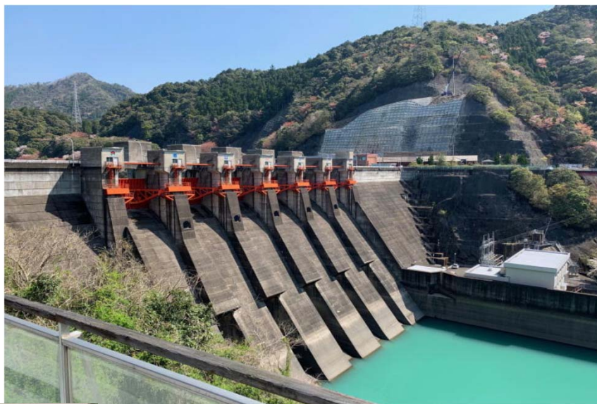
放流制御設備
