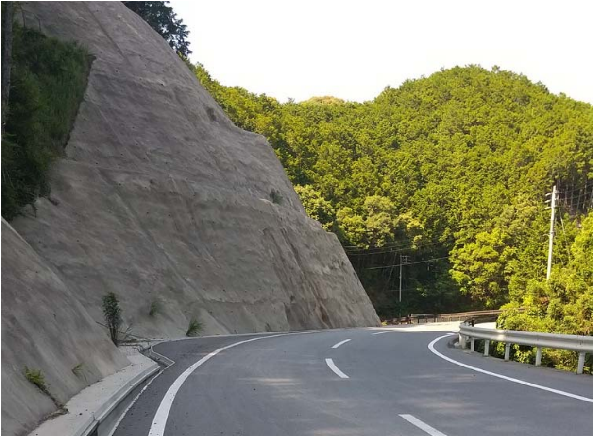
令和2年度完成工事 和歌山県優良工事表彰受賞工事（御坊中津線道路改良工事）
