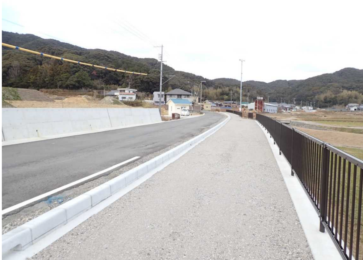
令和3年度完成工事 和歌山県優良工事表彰受賞工事（柏御坊線道路改良工事）
