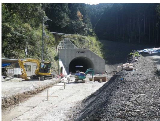
トンネル (H28. 12完成)
