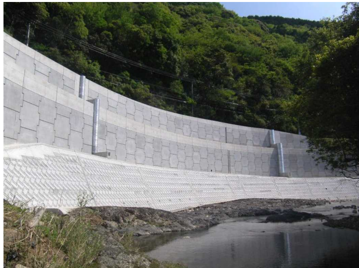
第13回和歌山県優良工事表彰受賞現場（国道425号）
