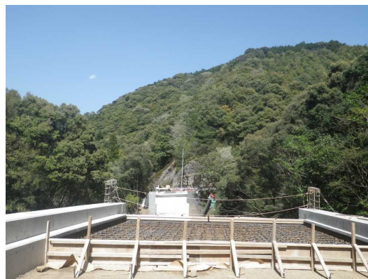
橋梁工事中 (H29. 5)
