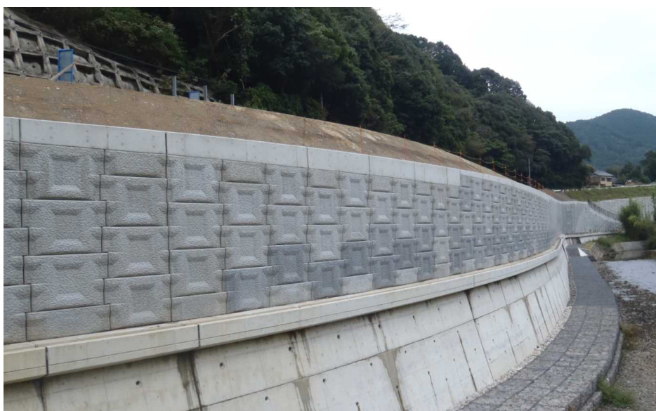
第14回和歌山県優良工事表彰受賞現場（国道424号）
