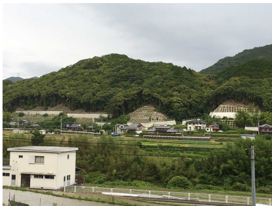
日高川町船津地区（日高川町船津地内）
