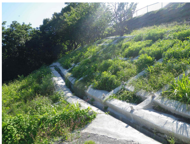
東岩代地区（みなべ町東岩代地内）
