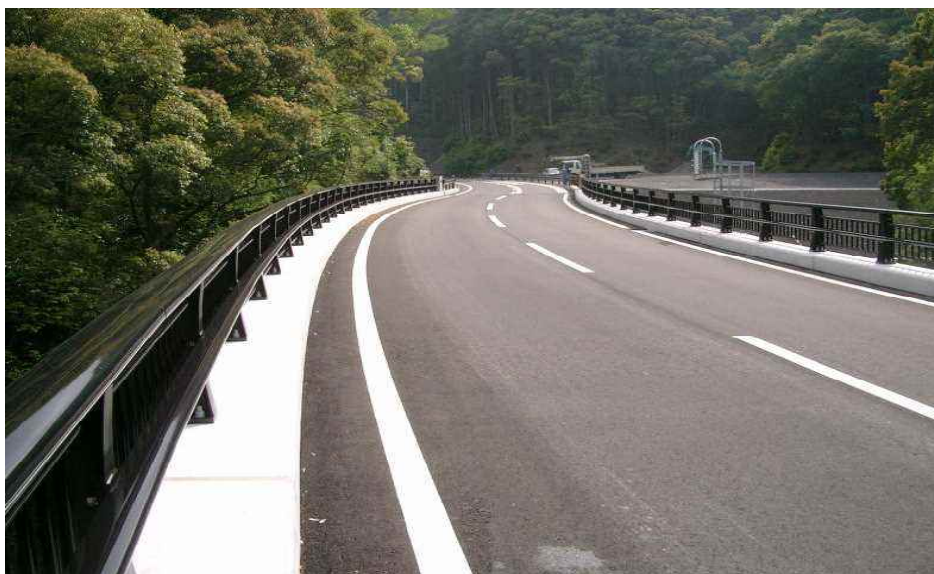
第15回和歌山県優良工事表彰受賞現場（県道芳養清川線）
