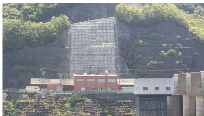
法面对策工事
